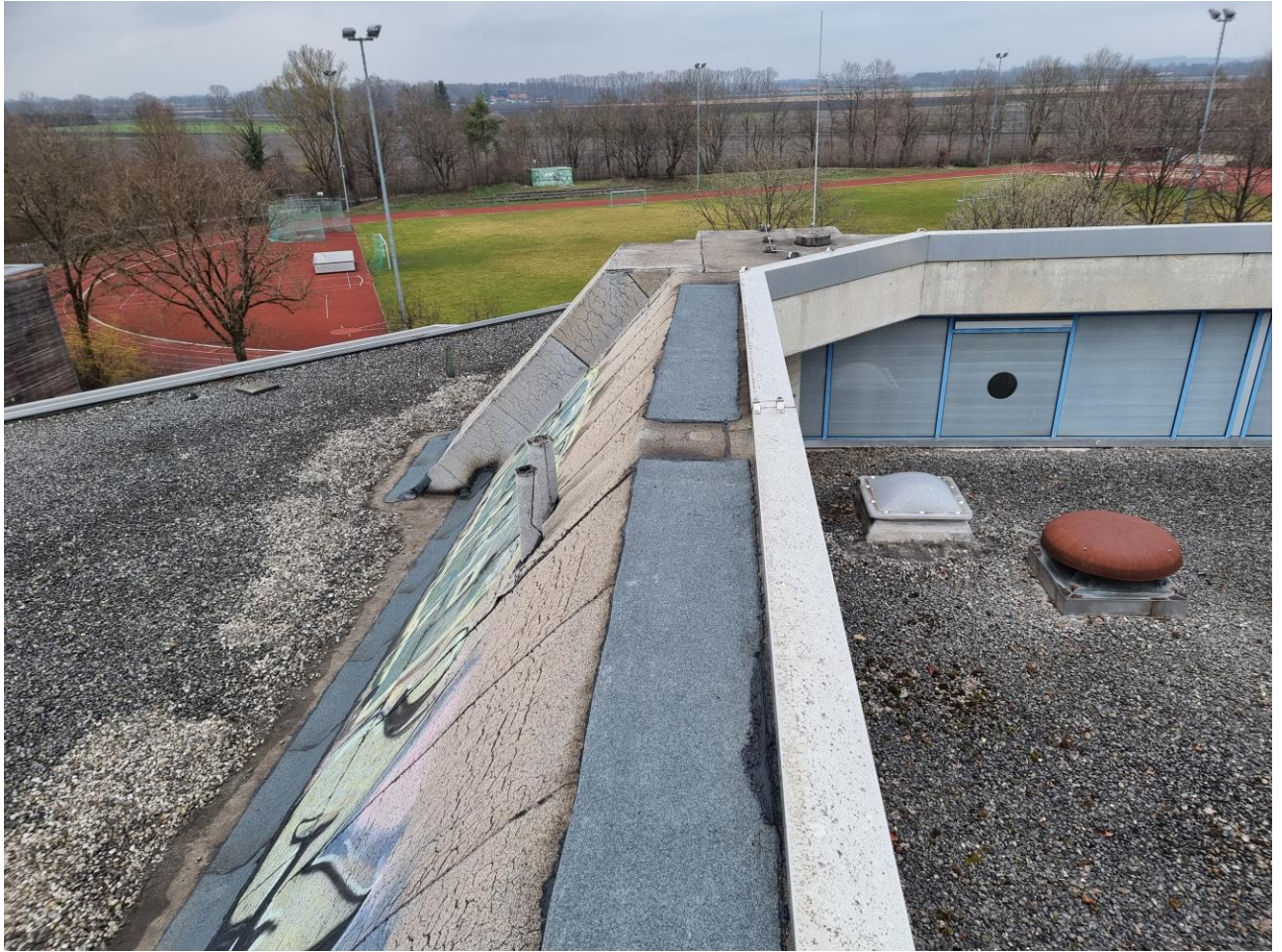
Dachfläche mit aufgehenden Sheddächern und Innendach
