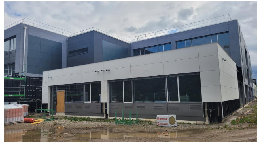
PV Anlage eingebaut
