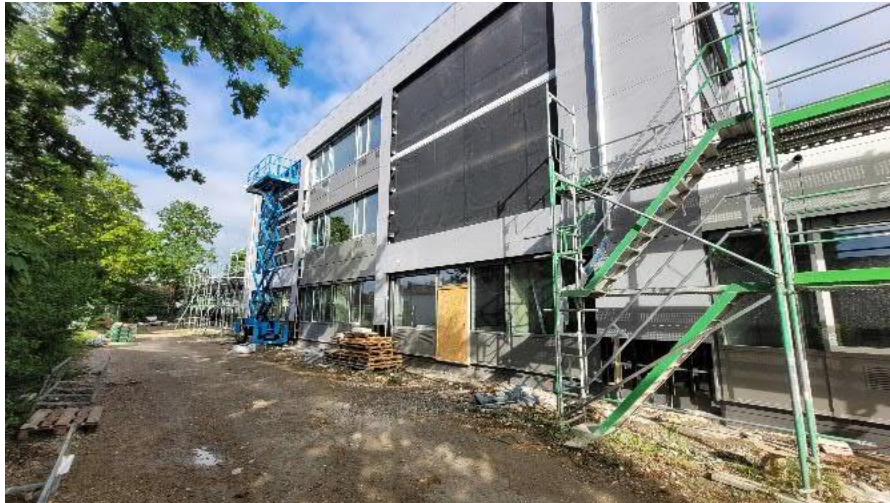
PV Anlage Montage
