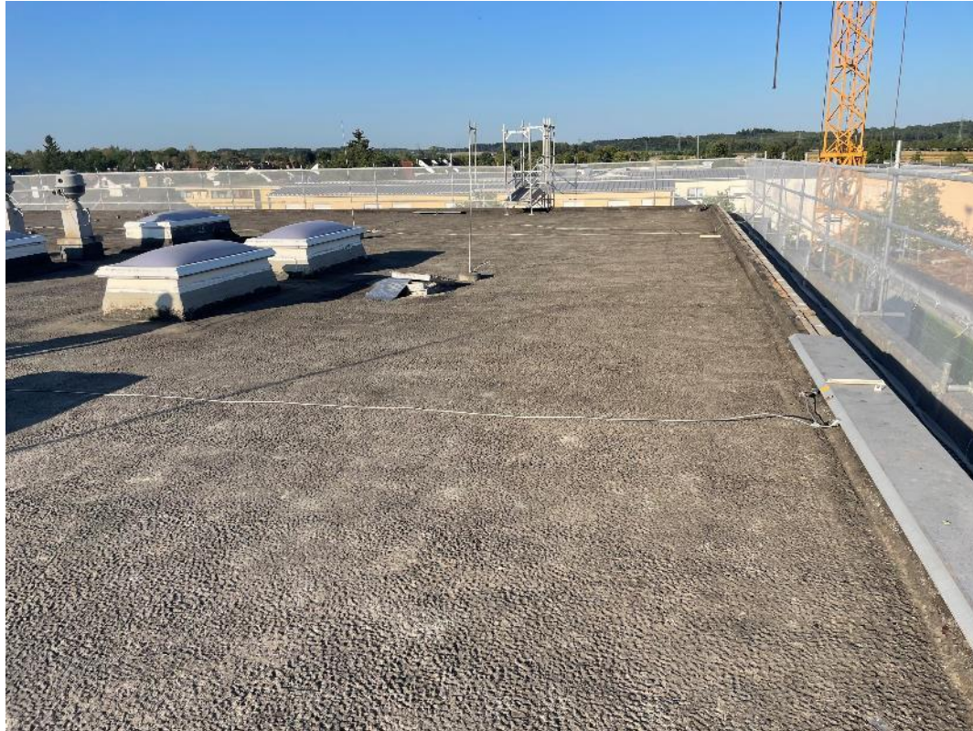
Dachfläche nach Kiesabsaugung
